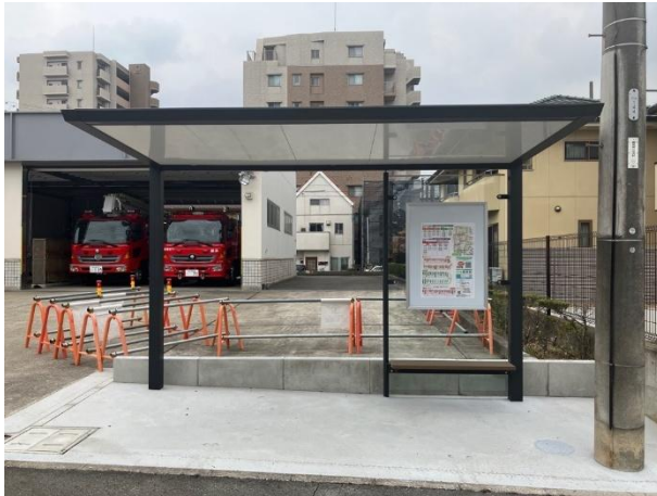
東海市消防署北出張所前バス停 上屋・ベンチ設置状況 (令和7年度設置)
