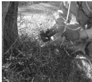
(写真32) 薬剤注入器での注入
