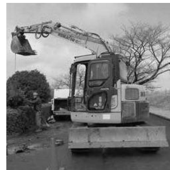
(写真23) 伐根作業
